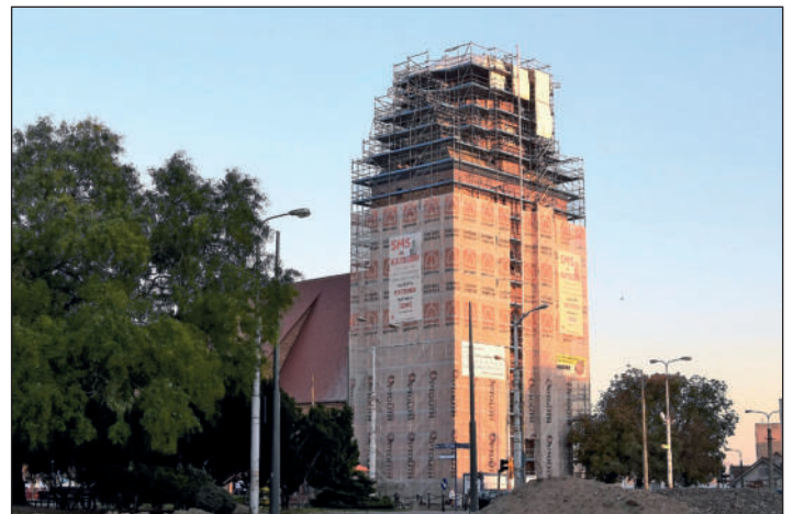
Sanierungsarbeiten an der Marienkirche und auf der Straße.
