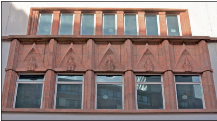
Deutschlandhaus: Denkmalgeschützte Elemente der Fassade wurden erhalten, dahinter entsteht ein moderner Neubau.
