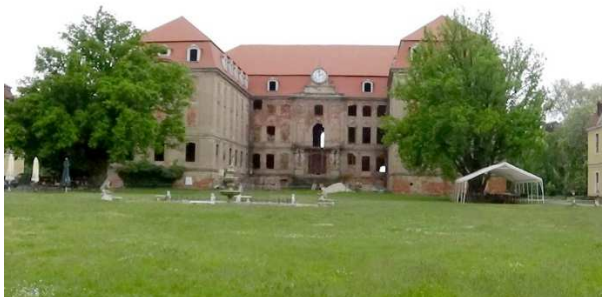
Pförten – Schlossruine: Bauherr v. Brühl
